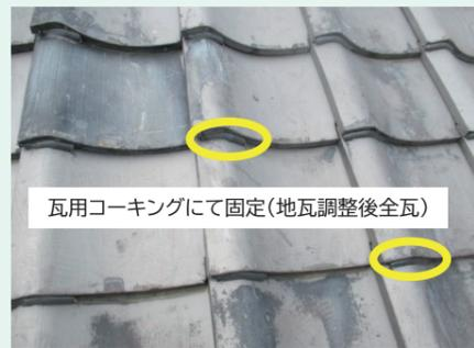
瓦用コーキングにて固定(地瓦調整後全瓦)
