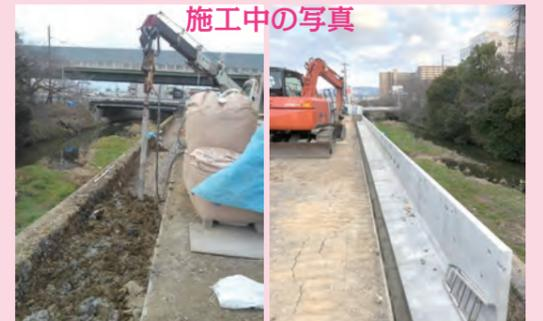
↑柱状地盤改良杭施工中 ↑L型擁壁組立完了
